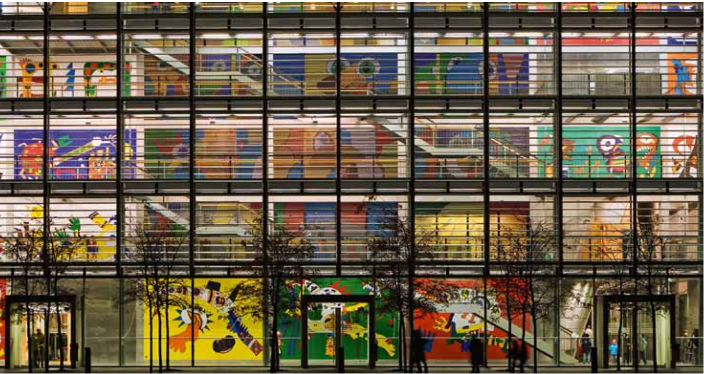
Technische Universität Dresden, Hörsaalzentrum, Foto: Lösel
