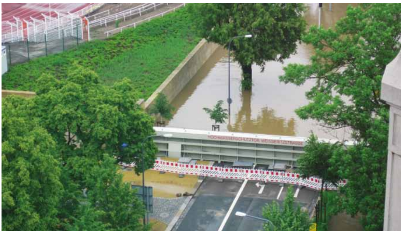
Hochwasserschutzanlage Weißeritzstraße, Foto: Stadtplanungsamt Dresden
