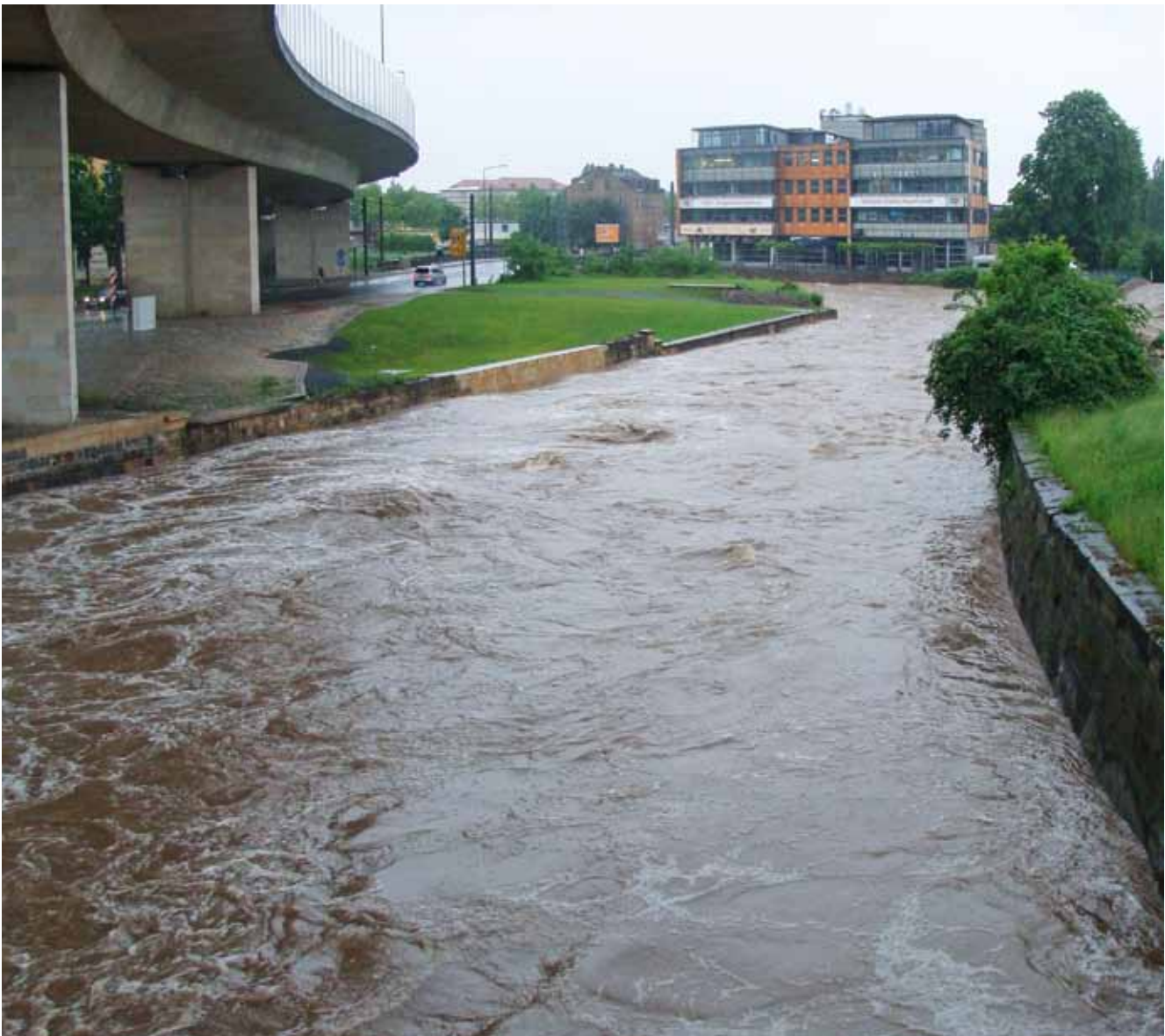
Vereinigte Weißeritz, Hochwasser 2013, Foto: Stadtplanungsamt Dresden
