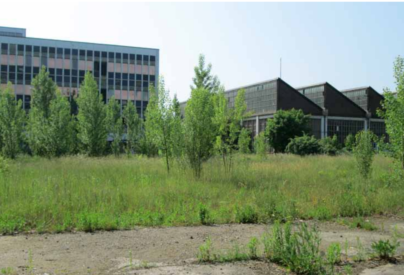
Brache Mügelner Straße in Reick, Foto: Stadtplanungsamt Dresden
